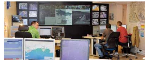
Ainsi, installé rue du Gabian, le CIGM dispose d'un mur d'écrans reliés aux caméras positionnées dans les rues de la Principauté et qui permet d'avoir en direct une vision globale de la mobilité
